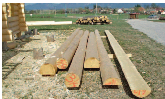
2 PŘÍPRAVA KULATINY: DŘEVO NA SRUB SE VĚTŠINOU VYBÍRÁ UŽ NA KMENI – TEDY JEŠTĚ NEPOKÁCENÉ V LESE. MĚLO BY POCHÁZET Z VYŠŠÍ NADMOŘSKÉ VÝŠKY, ALEŠPOŇ 600 M N. M. A Z VNITŘNÍCH ČÁSTÍ LEŠA, KDE STROMY MAJÍ OPTIMÁLNÍ SBÍHAVOST. VYBRANÉ KMENY STROMŮ SE PAK DOVEZOU DO VÝROBNÍHO AREÁLU, KDE SE RUČNĚ ZBAVÍ KŮRY A LÝKA. NÁSLEDNĚ SE JEDNOTLIVÉ KLÁDY USKLADNÍ NA VYVÝŠENÉ DŘEVĚNÉ KONSTRUKCI TAK, ABY KOLEM NICH MOHL OPTIMÁLNĚ PROUDIT VZDUCH. PO VYTVOŘENÍ MIKRO VÝSUŠNÝCH TRHLIN SE VYŘADÍ TOČITÉ KUSY, KTERÉ NEJSOU PRO STAVBU SRUBU VHDNÉ. NA VÝSUŠNÝCH TRHLINÁCH JE TOTIŽ VIDĚT, ZDA A JAK JE DŘEVO TOČITÉ. PŘI POUŽITÍ TOČITÉ KLÁDY DO SRUBOVÉ STĚNY HROZÍ RIZIKO, ŽE SE VLIVEM KROUČENÍ DŘEVA OTEVŘE PODÉLNÁ DRÁŽKA A DOJDE K NETĚSNOSTI. TOČITÉ KLÁDY TAKÉ VÍCE PRASKAJÍ, DO TRHLIN MŮŽE VNIKAT VODA, A POKUD SE SITUACE NEŘEŠÍ, MOHLO BY DOJÍT KE VZNIKU HNILOBY
