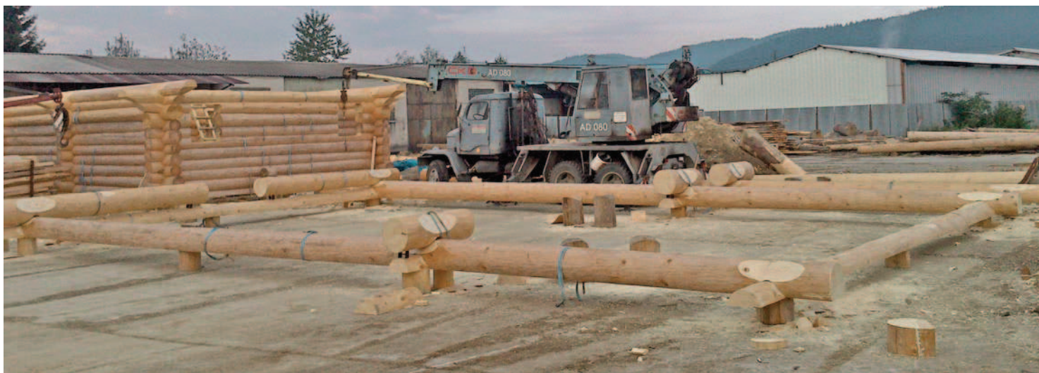
3 ZALOŽENÍ STAVBY PROBÍHÁ NA PODKLADNÍCH ŠPALCÍCH, S JEJICHŽ POMOCÍ SE VYTVOŘÍ ROVINA. STĚNY SE ZAKLÁDAJÍ PODLE OSOVÝCH ROZMĚRŮ, DANÝCH VÝROBNÍ DOKUMENTACÍ
