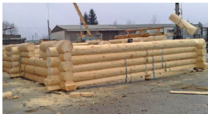
5 U VŠECH PODÉLNÝCH I ROHOVÝCH SPOJŮ MUSÍ BÝT POČÍTÁNO S NÁSLEDNÝM VYSYCHÁNÍM A SEDÁNÍM STAVBY. PŘI VÝROBĚ MOHOU BÝT MEZI JEDNOTLIVÉ KLÁDY VKLÁDÁNY ÚVAZKY, POMOCÍ KTERÝCH SE PAK PŘI ROZEBÍRÁNÍ SRUBU S JEDNOTLIVÝMI KLÁDAMI MANIPULUJE
