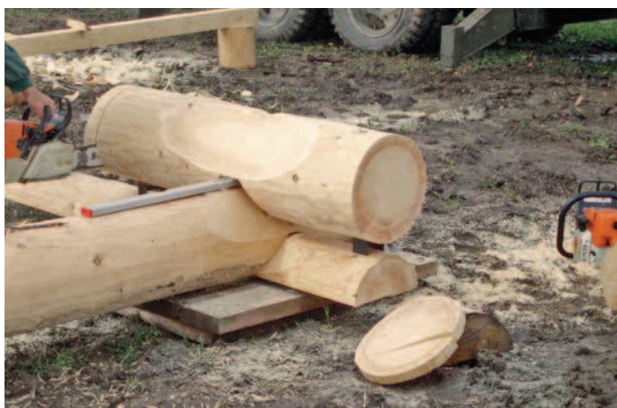
3 ZALOŽENÍ STAVBY PROBÍHÁ NA PODKLADNÍCH ŠPALCÍCH, S JEJICHŽ POMOCÍ SE VYTVOŘÍ ROVINA. STĚNY SE ZAKLÁDAJÍ PODLE OSOVÝCH ROZMĚRŮ, DANÝCH VÝROBNÍ DOKUMENTACÍ
