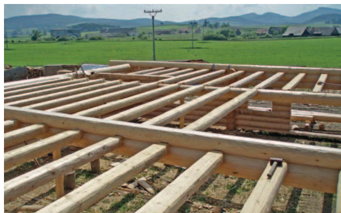
6 STROPNÍ TRÁMY NAD PŘÍZEMÍM JSOU Z HORNÍ HRANY SEŘÍZNUTÉ A OSAZENÉ DO ROVINY, ČEHOŽ SE DOSÁHNE DÍKY ČEPŮM VYROBENÝM NA OBOU KONCÍCH TRÁMŮ
