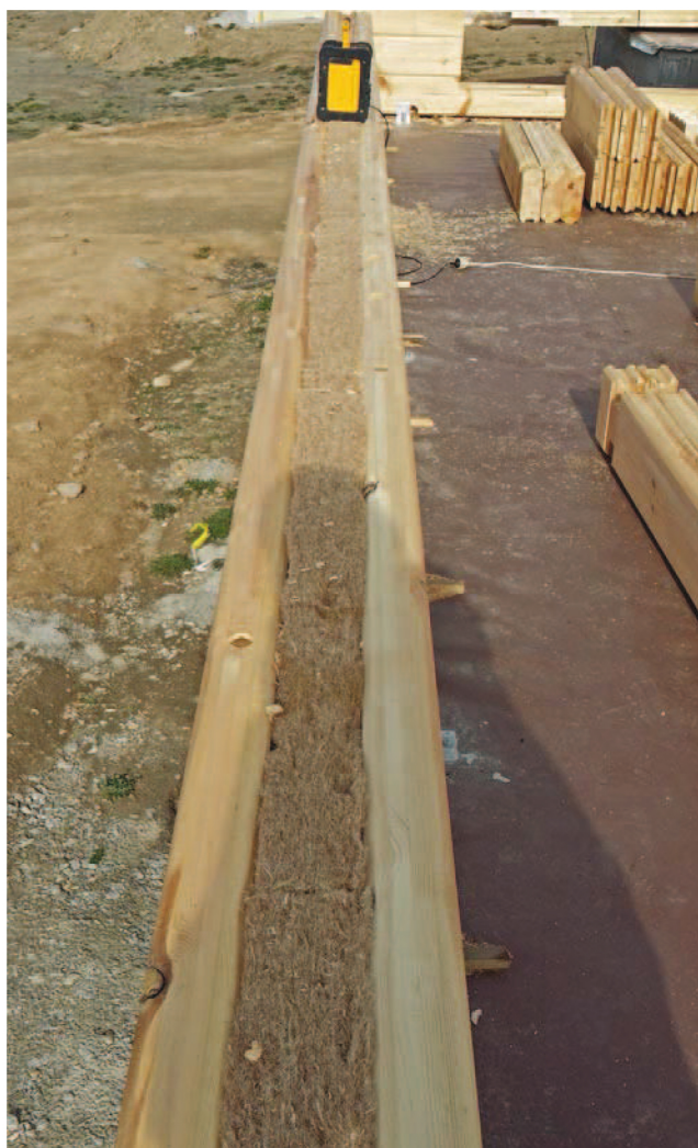
CESTOU K NÍZKOENERGETICKÉ ROUBENCE MŮŽE BÝT DVOJITÉ ROUBENÍ S VLOŽENOU TEPELNOU IZOLACÍ
